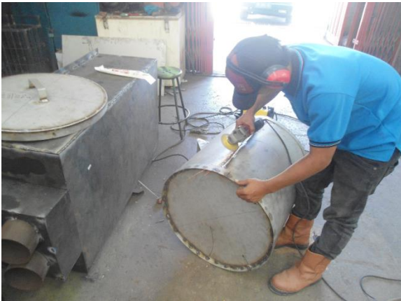
Gambar 7. Proses Pemasangan Penguat Presto
