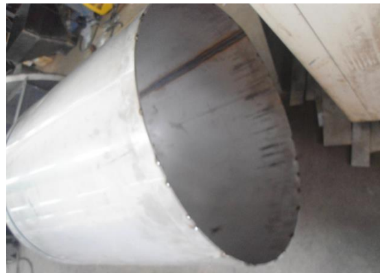
Gambar 4. Proses Pengerolan dan Pengelasan Material Silinder Presto
