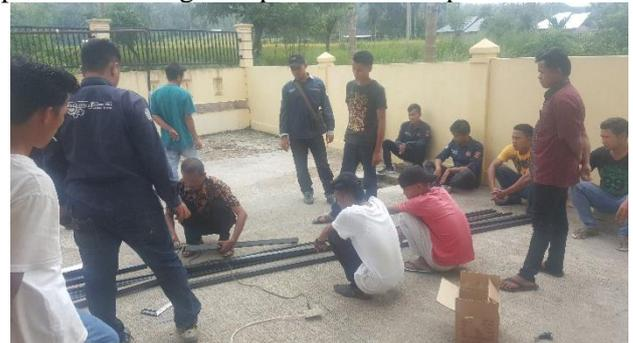
Gambar 12. Proses Pemotongan Besi Stalbus
