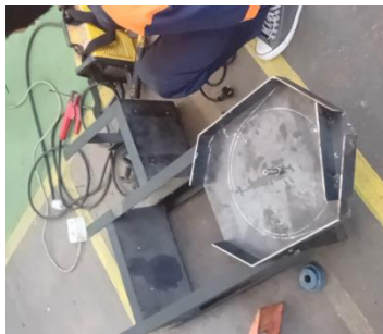
Gambar 9. Proses Pemasangan Ruang Penggiling Pada Rangka
