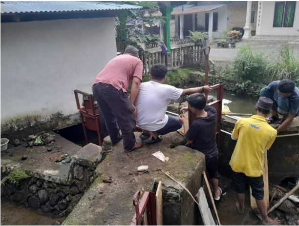
Gambar 3.6. Pemasangan konstruksi PLTPH pada Saluran Irigasi
